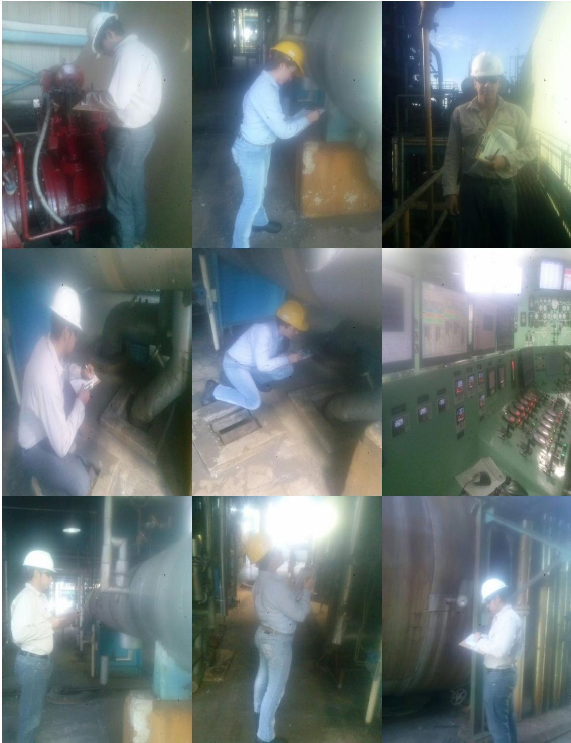
Figura 5 Representación del registro del comportamiento de la unidad generadora, donde se analizan parámetros de presión, temperatura en las extracciones de la unidad.
