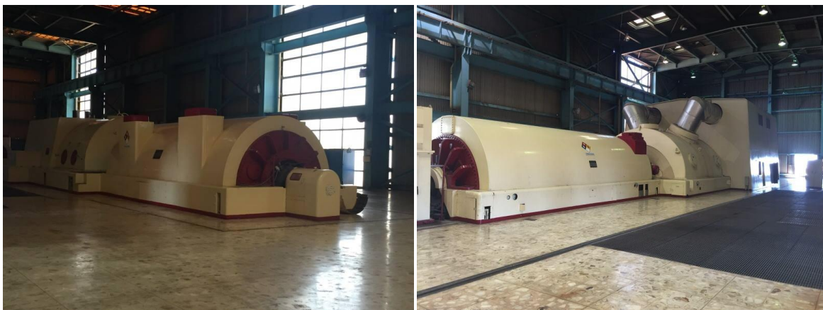
Figura 1 Representación de las unidades turbogeneradoras de la central termoeléctrica José Aceves pozos el cual está compuesta por dos de 158 MW y una de 300, MW el cual hacen un total de 616 MW de operación nominal a máxima cada 6 meses.
